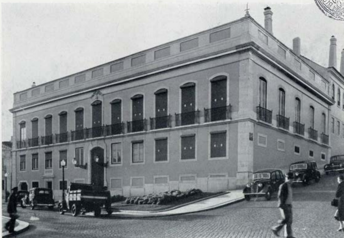
Fachada sobre o Largo do Rato e Calçada Bento da Rocha Cabral (pág. 49)
