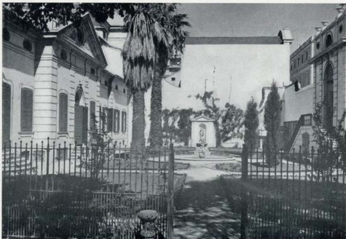
Aspecto da fachada Sul e dos antigos jardins (pág. 45)
