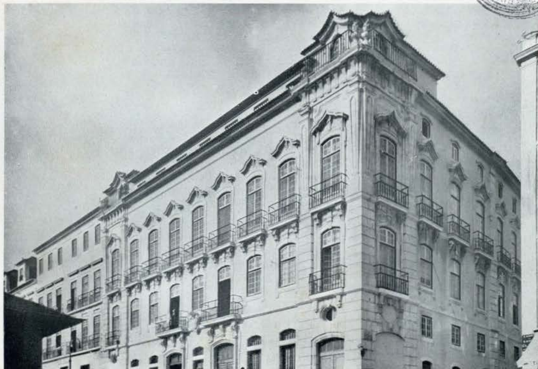
Fachadas Sul e Nascente, no Campo de Santa Clara — Rua da Verónica (pág. 41)
