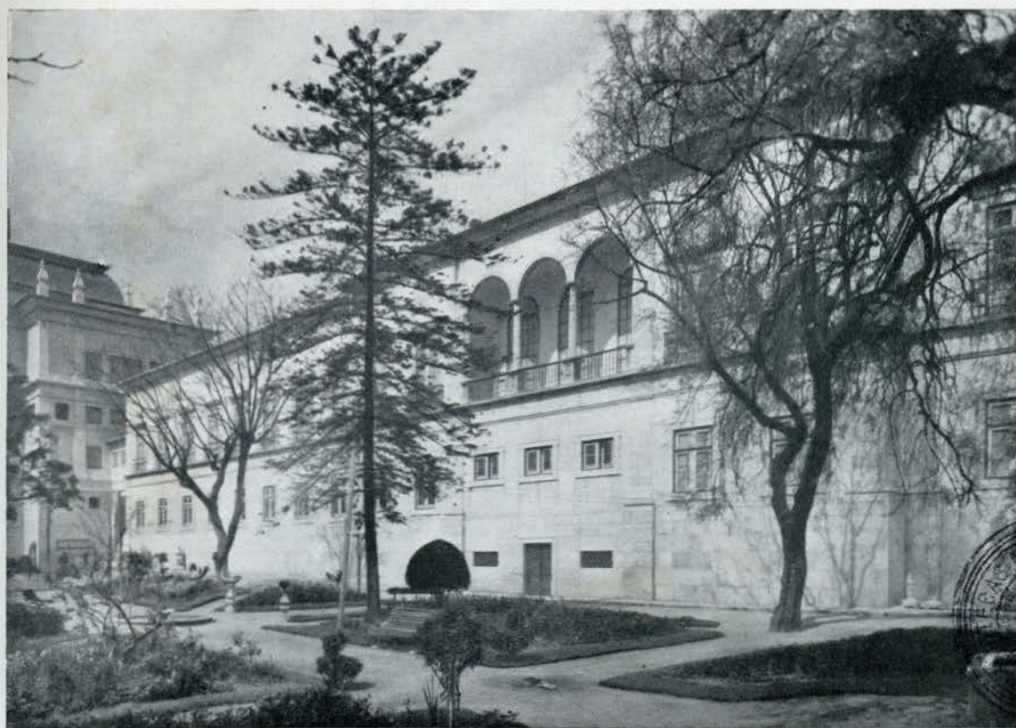
Fachada Sul, sobre o jardim, vendo-se a triplice arcaria central construída recentemente
