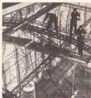
Nos estaleiros de Friedrichshafen reina uma actividade febril. Ultima-se a construção da armadura metálica dum novo dirigível do tipo Zeppelin que passa a ser designado simplesmente por L. Z. 129.
