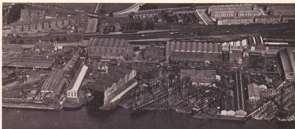
Vista aérea dos estaleiros Yarrow, onde se estão construindo as caldeiras e outros apetrechamentos para os novos contra-torpedeiros
