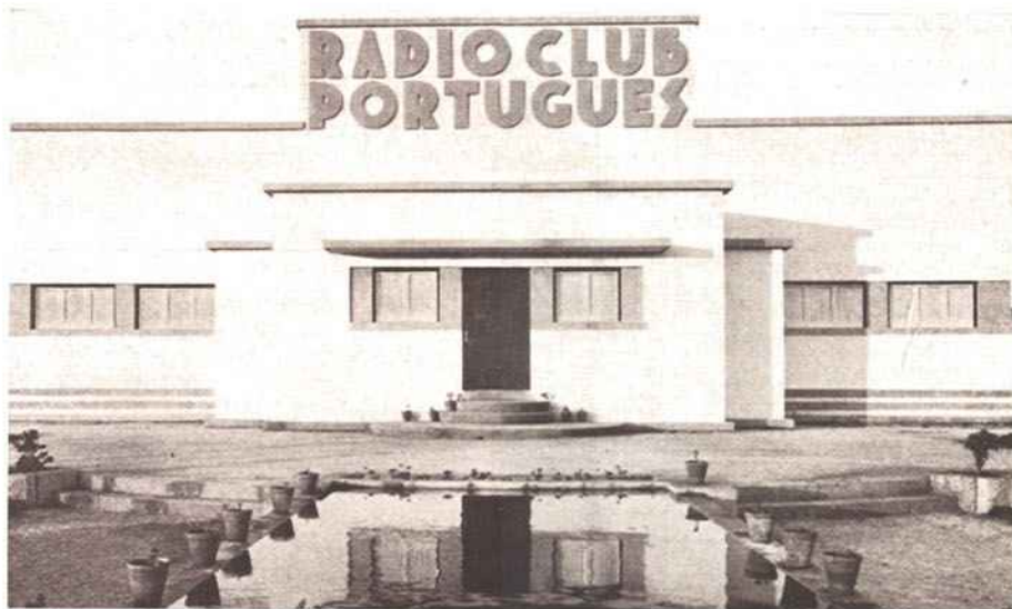
O novo edifício do «Rádio Club Português».
