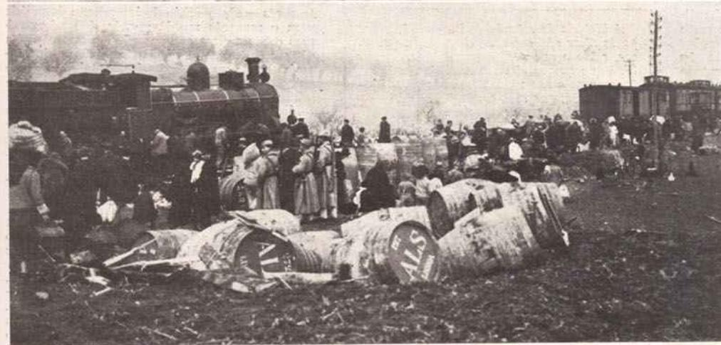
O descarrilamento foi preparado sobre um pequeno viaduto, tendo sido levantado um carril do lado interior da linha ascendente. A máquina e o furgão foram enterrar-se na brita, depois de terem galgado aos saltos alguns metros do percurso. Dos 52 vagons, de que se compunha o combóio, ficaram destruídos, ou seriamente avariados 23, computando-se nalgumas centenas de contos os prejuizos. O aspecto que alguns deles ofereciam, encavalitados uns nos outros, nas formas mais caprichosas, era singular.
