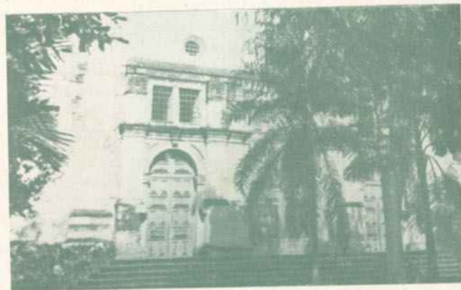
IGREJA SACRIFICADA AO PROGRESSO — Na cidade da Ilha a perfeitura teve de sacrificar a velha Igreja da Sé para abrir uma larga avenida. Era uma reliquia do velho Brasil. A sua construção data de alguns séculos. Era das mais antigas do Brasil.
