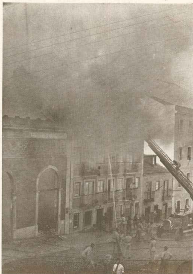
Um aspecto do incêndio
