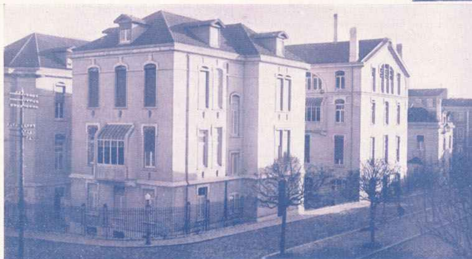
Aspecto lateral das alas do enorme edifício da «Maternidade», onde se encontram instaladas as clínicas ginecologia e obstetrícia
