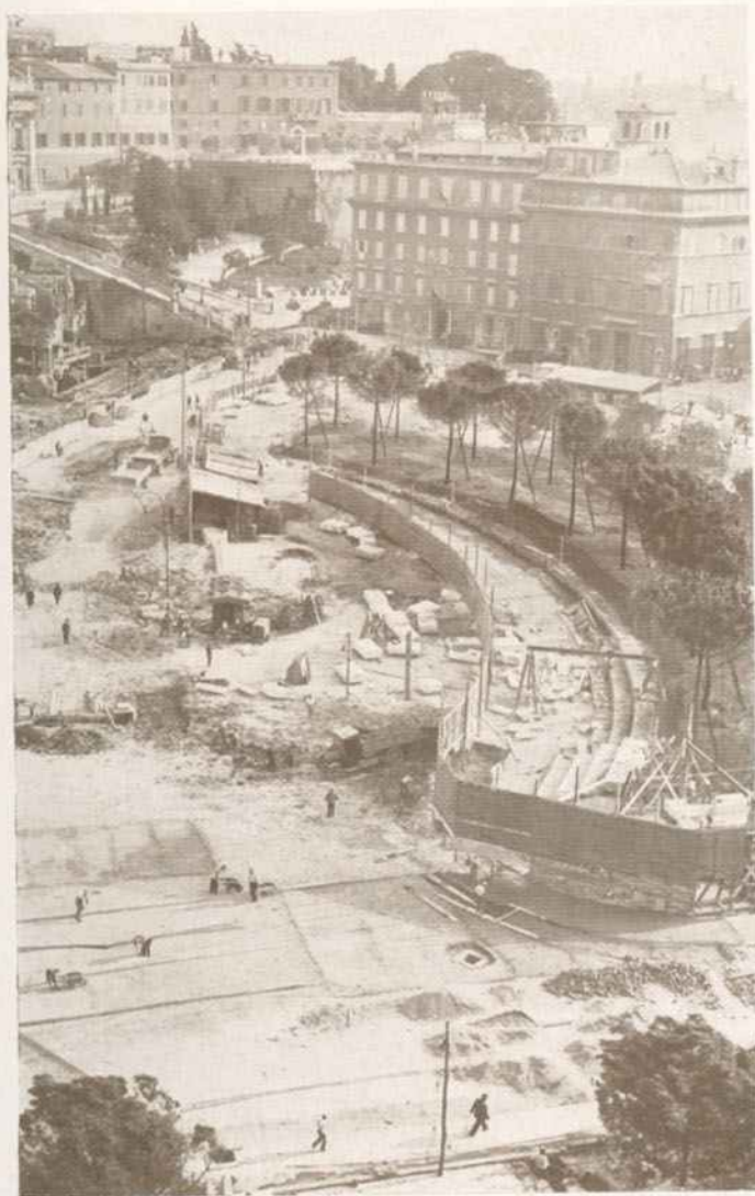
Obras na Via del Mare em parte sacrificada pelas novas escavações
