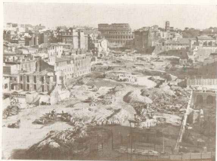
Obras da abertura da Via del Impero ao fundo da qual aparece o Coliseu
