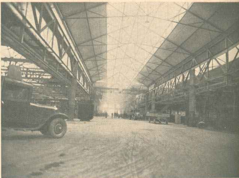
Uma grande nave de perto de 300 metros de comprimento numa fábrica de automóveis
