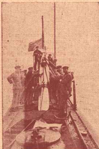
Depois dos exercícios, o torpedo é introduzido verticalmente no submarino
