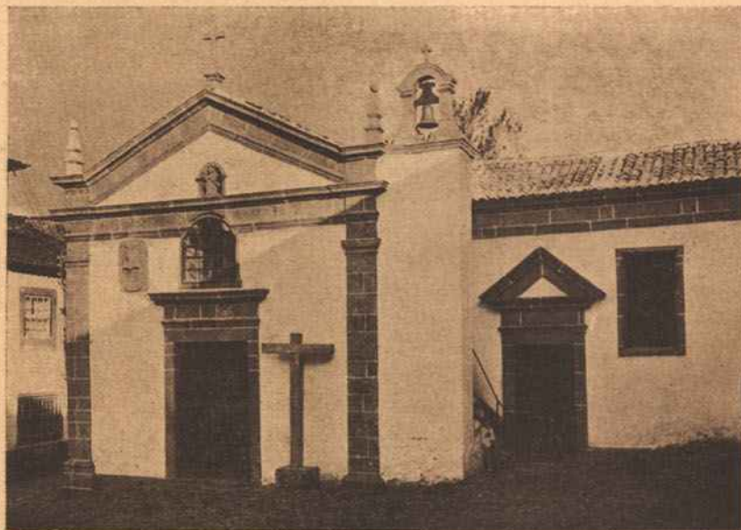
PONTE DA BARCA — Capela da Lapa, dos Soutos-dei-Rei
