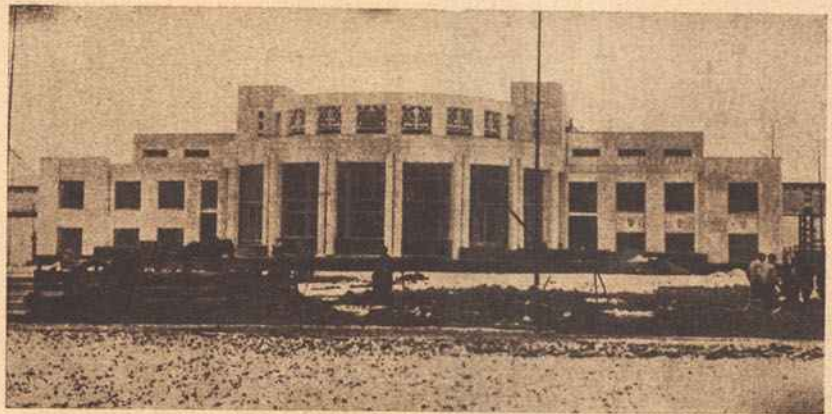
Fachada do enorme Palácio do Centenário
