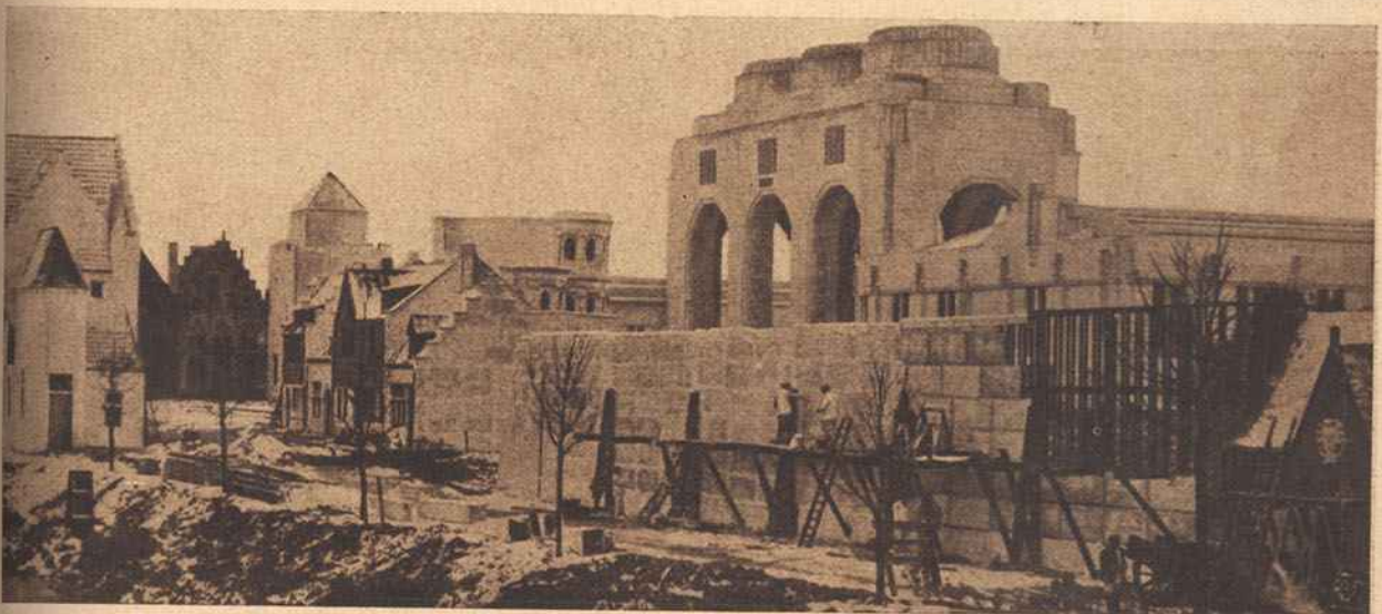
da «Vieille Belgique» (em construção)
