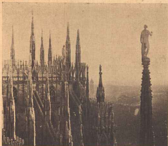
O extremo do transepto do «Duomo» de Milão, visto dum dos cornéus, sendo de notar as estatuetas de tipo pagão que rematam algumas flechas góticas ousadas e rendilhadas finamente
