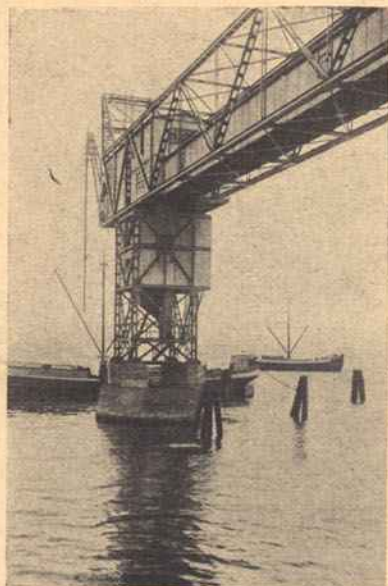
A torre de aspiração junto à amarração dos vapores
