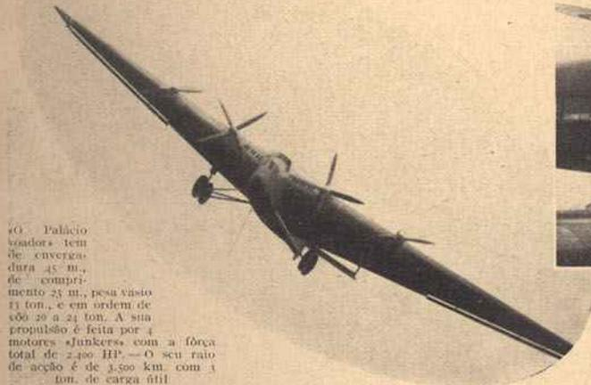
O «Palácio Voador» tem de envergadura 45 m., de comprimento 23 m., pesa vazio 11 ton., e em ordem de voo 20 a 24 ton. A sua propulsão é feita por 4 motores «Junkers» com a força total de 2.400 HP. — O seu raio de acção é de 3.500 km. com 1 ton. de carga útil
