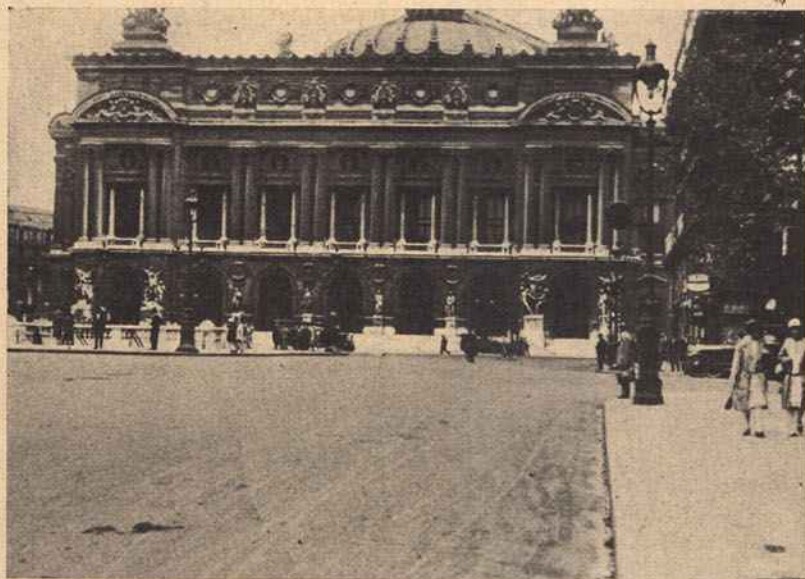
Edifício da Grande Opera de Paris
