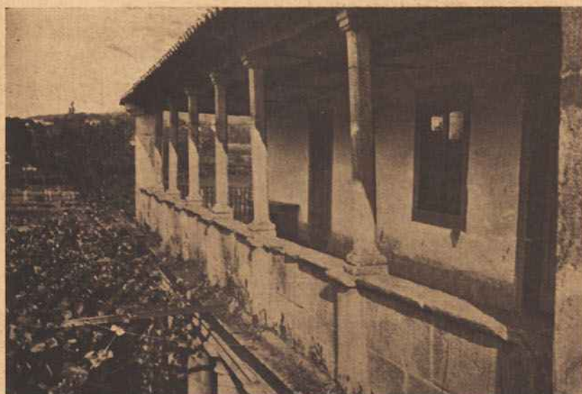
Casa de Crasto em Ponte do Lima
