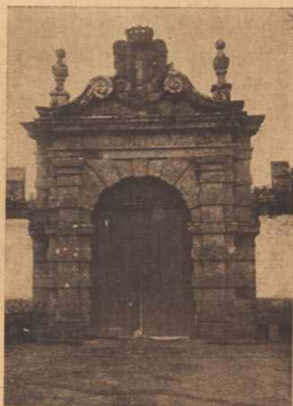
PONTE DO LIMA. — Portal e braço de armas do Paço de Vitorino
