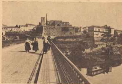
Vista da ponte sobre o rio Tejo, em Beja, com a igreja de São João do Castelo ao fundo.
