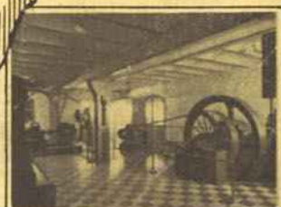
Motores, transformadores, dinamos, etc
