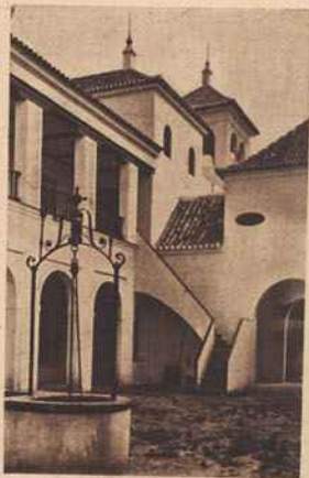
Pátio típico no Pavilhão do Azeite
