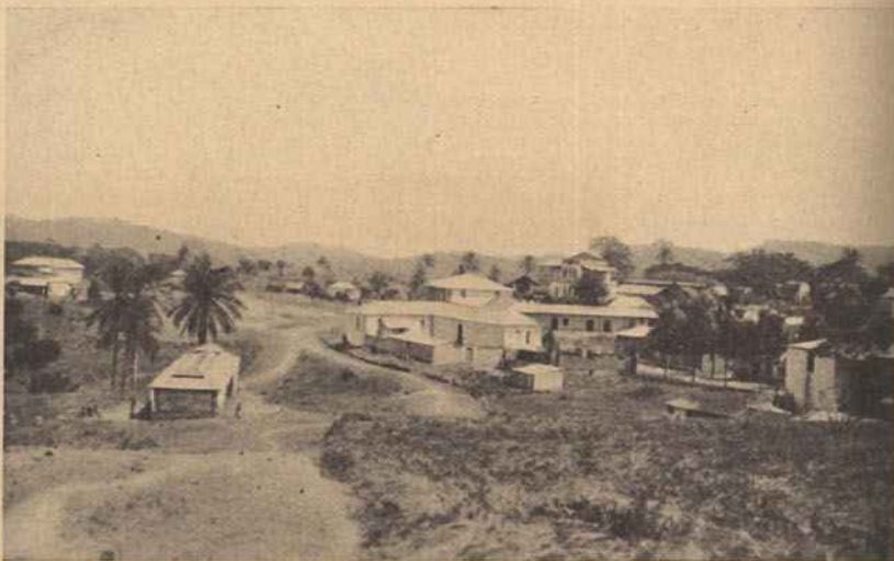
Um aspecto da vila de Golungo-Alto, depois do saneamento
