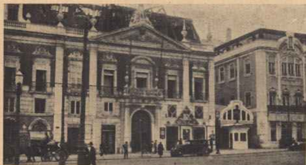
Aspecto do Palácio Foz vendo-se os prejuízos causados pelo fogo, e à direita o horrível pavilhão construído pela Carris e que, entalando a Calçada da Glória, insculpa que se derrubasse o fogo
