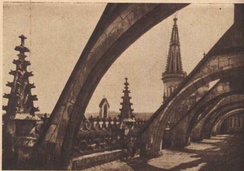
1 BATALHA — Vista dum passadiço do segundo pavimento
