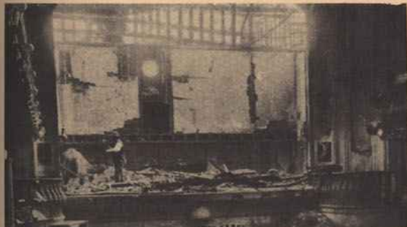
O salão do Salão Foz, depois do incêndio que o devorou, causando graves prejuízos ao Palácio Foz, e posto em perigo, pela costumada falta de água, o riquíssimo salão do mesmo edifício, que é dos mais belos do país
