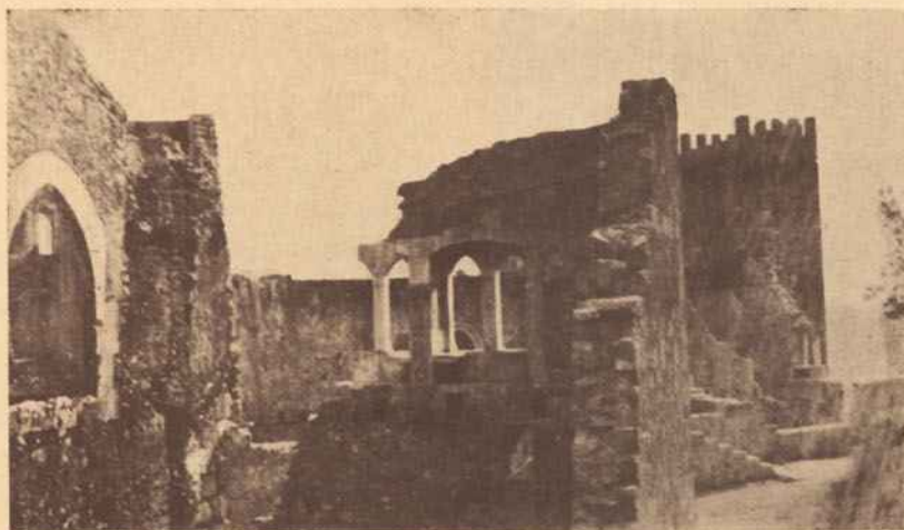
No Castelo de Leiria — Aspecto das muralhas
