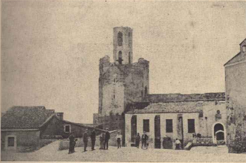
BADAJOS — Torre de Espantaperros
