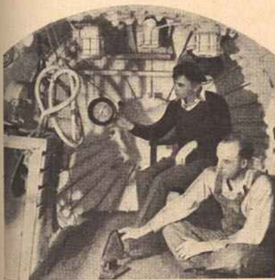
O interior da câmara de compressão
