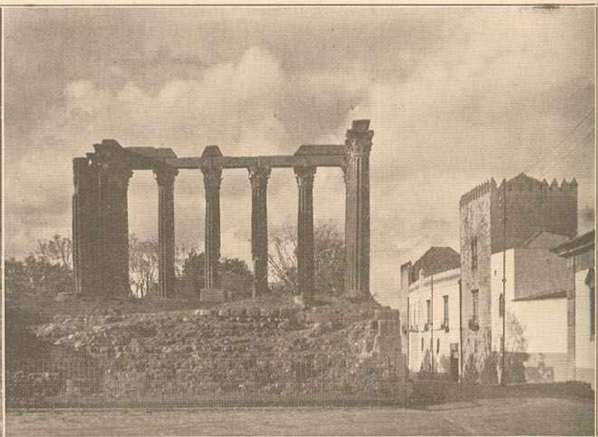
EM EVORA — O templo de Diana, uma joia maravilhosa de arquitectura clássica, desgraçadamente desmantelada pelo tempo
