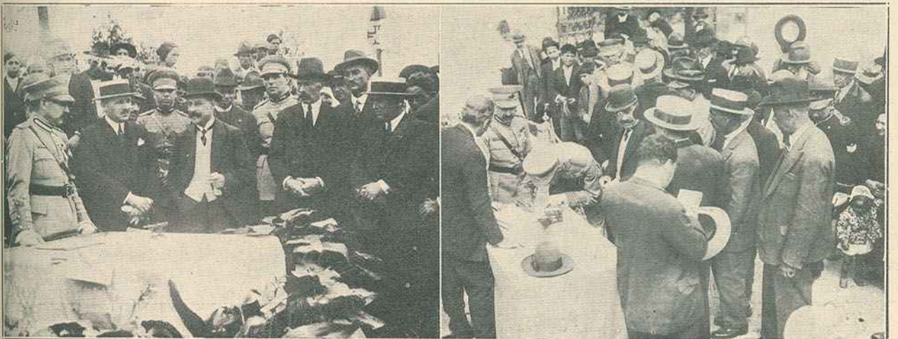
Assinatura do auto de lançamento da primeira pedra da escola de Triana, freguesia do Rio Tinto, com a assistência do governador civil do Porto e comandante da 1.ª região militar. — No cemitério da mesma freguesia: cerimónia da cedência pela respectiva junta dum talhão para sepultura dos combatentes da Grande Guerra, por iniciativa do administrador de Gondomar
