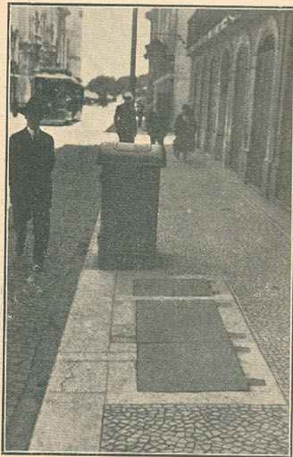
A entrada, na rua da Prata, para as termas romanas e, possivelmente, para a galeria subterrânea do Castelo de S. Jorge.
