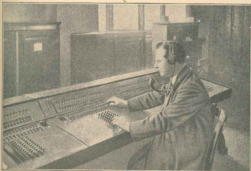
Aparelho especial permitindo passar as comunicações de um sector de telefone automático para um sector de telefone manual
