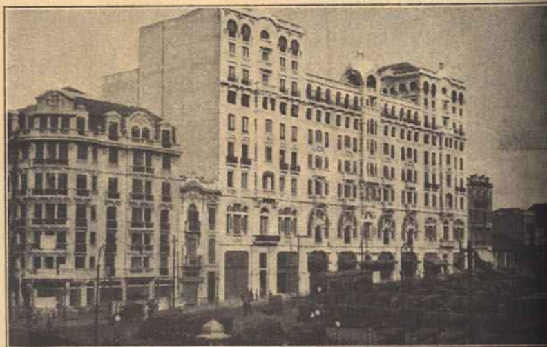
Praça da Catedral e prédio onde funciona o Teatro Santa Helena
