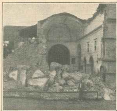
A igreja da N. S. da Conceição, em ruínas
