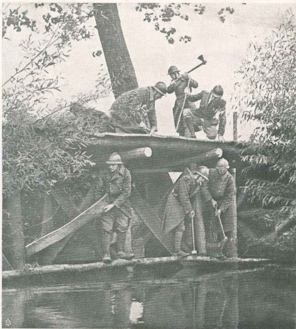
O mais banal meio de defesa que um exército encontra quando recua, é fazer saltar as pontes para atrazar o avanço dos seus perseguidores. Estes, por sua vez, como a gravura acima indica, servindo-se dos seus pontoneiros constroem rapidamente uma ponte para a passagem da sua artilharia
