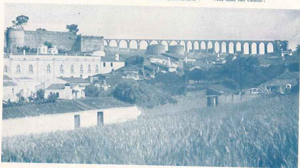
Vista de parte das muralhas e do Aqueduto de Serpa
