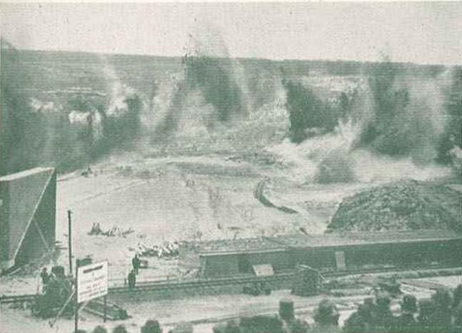
Sistema prático adoptado pelos alemães para a construção de auto-estradas. Os pantanos são rebentados por sucessivas explosões, encontrando-se base sólida a 11 metros de profundidade
