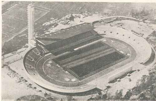
O estado actual das obras de ampliação do estádio de Helsinki onde terão lugar os Jogos Olímpicos de 1940, vendo-se em torno os numerosos campos destinados aos torneios de futebol e hockey
