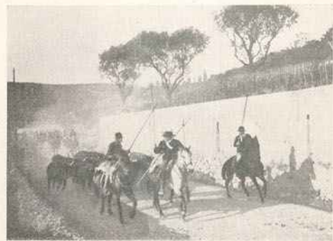
A passagem de tropas na Calçada de Carriche
