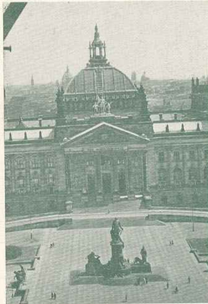
Um aspecto do edifício do Reichstag com as suas modificações
