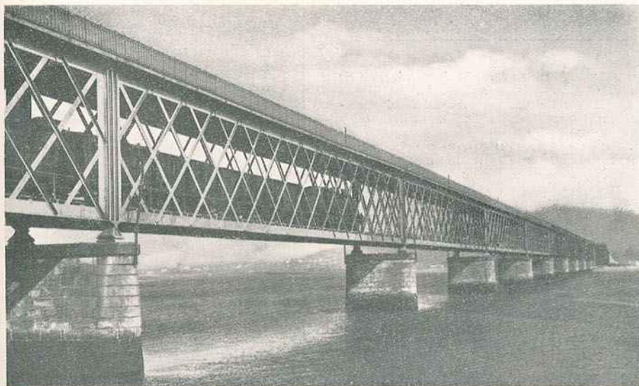
Ponte metálica sobre o Rio Lima
