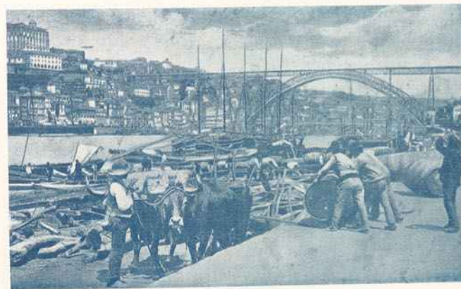
Trabalho na margem do Douro
