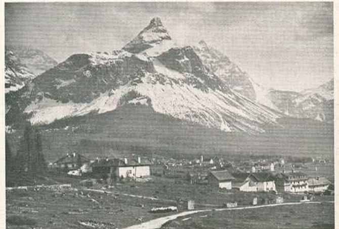
Um aspecto do monte Zugspitze em que, após um trabalho de 4 meses foi construído um túnel de 800 metros de comprimento, ligando assim o caminho de ferro bávaro com o tirolês
