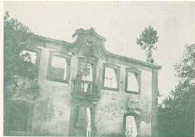
A Albergaria, chamada na região a Casa dos Terceiros
