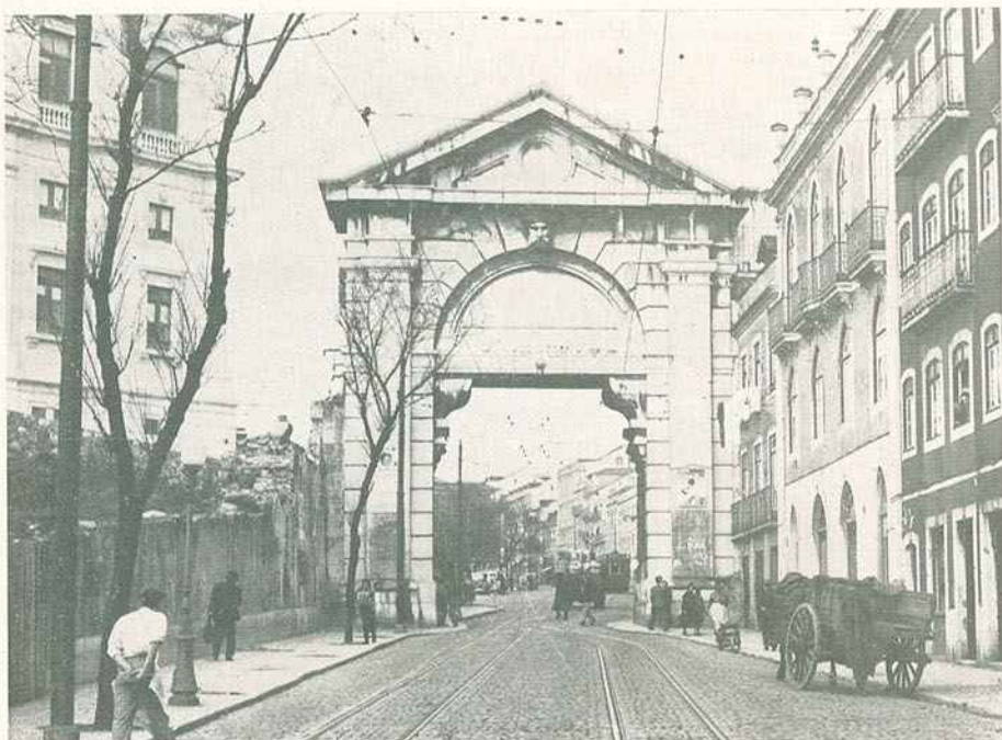
O velho Arco de S. Bento que vai ser demolido para embelezamento da cidade, visto o plano das obras do Palácio do Congresso assim o exigir
