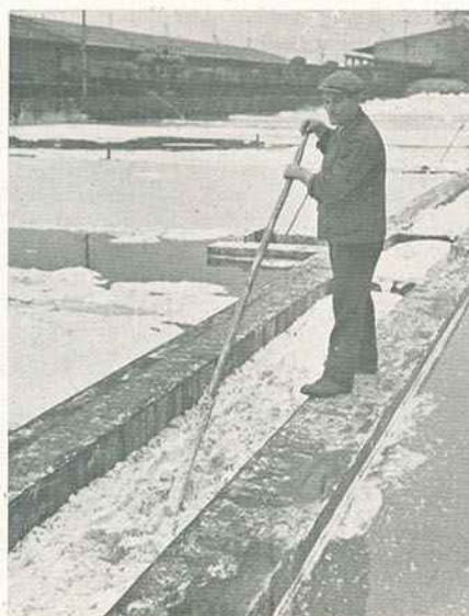
Depósito em que se clarifica o amido extraído das batatas na Alemanha
