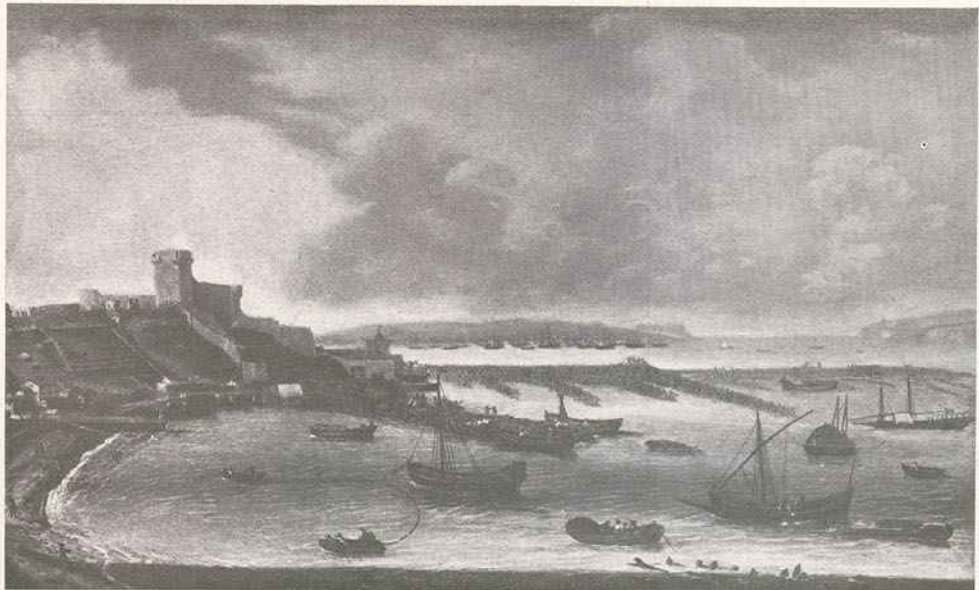
A evacuação de Tanger e a demolição do cais
