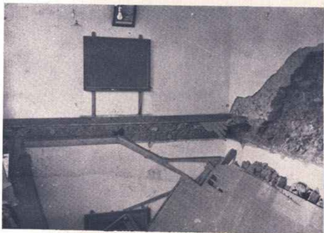
A sala em que se deu a catástrofe, vendo-se ainda a frágil consistência das vigas em que o sobrado abatido se apoiava, em face do que o sr. ministro da Educação Nacional ordenou um rigoroso inquérito. — Em baixo: a saída de um dos féretros à porta da igreja da vila.
