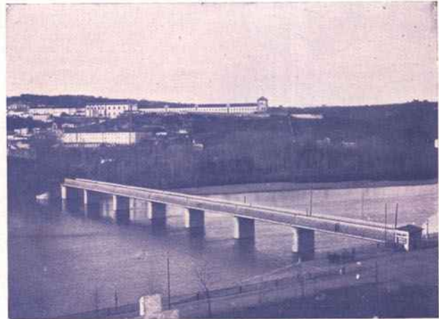
A ponte da Portagem
