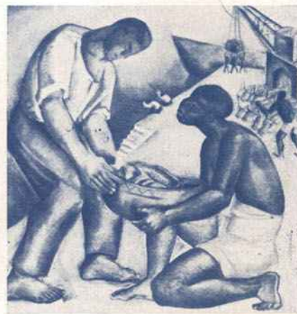
Obras Públicas nas Colónias , por Armando Lucena — O desenvolvimento dos meios de comunicação, principalmente em Angola e Moçambique, recebeu um notável impulso. Nesta última colónia constituíram-se em seis anos 350 quilómetros de via férrea e 9.000 quilómetros de estradas. Em Angola o aumento da rede de estradas no período que vai de 1926 a 1924 foi de cerca de 10.000 quilómetros.
