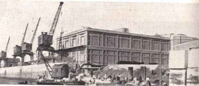
Construção do cais da 3ª secção
