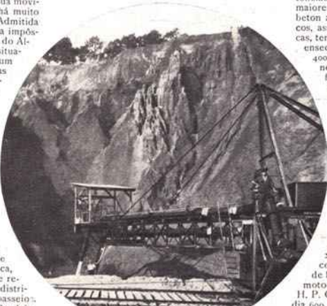
Desmonte hidráulico da barreira
