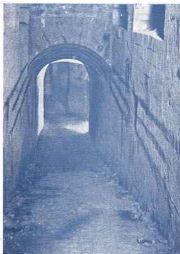
Entrada duma galeria que se encontra no subsolo de Paris
