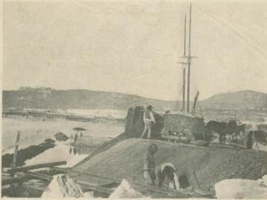
SETUBAL.—AS OBRAS DE ATERRO, E CONSTRUÇÃO DA NOVA MURALHA-BAMPA
