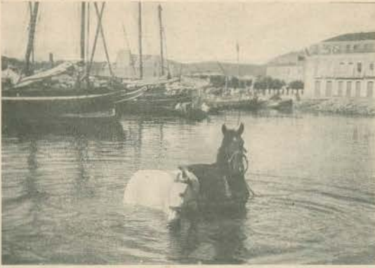
SETUBAL.—SITIO DO CAES DO CARYÃO QUE VAE SER ATERADO PARA A CONSTRUÇÃO DO «PERDE»
