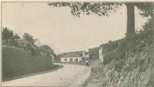
ENTRADA DO LADO SUL EM CARRIL
