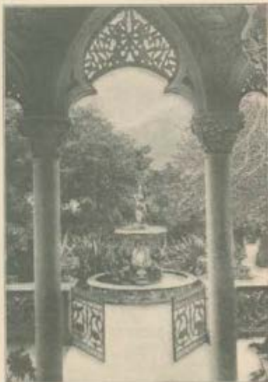
ESTACIÃO DE VERÃO: CINTA—VISTA DO LAJO DO PALACIO DE MOUSERRATE
