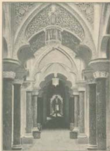
ESTACIÃO DE VERÃO: CINTA—A GALERIA EXTERIOR DO PALACIO DE MOUSERRATE
